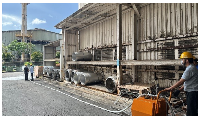
滅火器無法撲滅火勢改以操作泡沫式設備 (避免泡沫噴入油池，採戶外演練)
