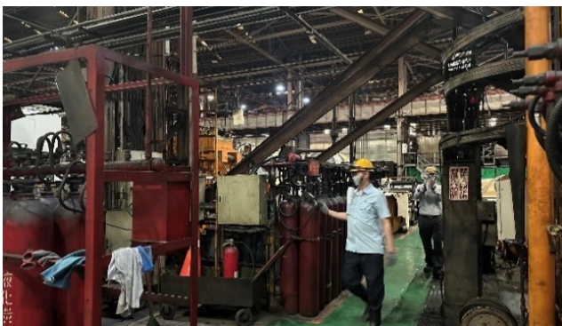
油池邊查看發現油池失火
