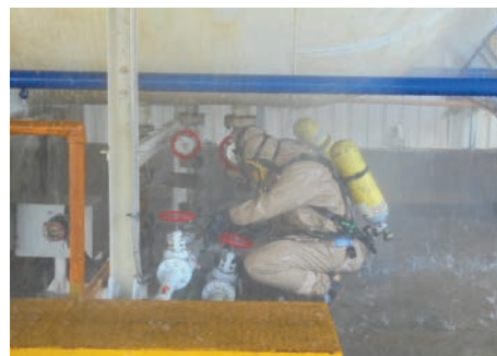
搶救人員著裝完畢進入氨槽關閉遮斷閥
