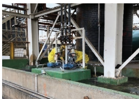
氫氟酸洩漏處搶修
