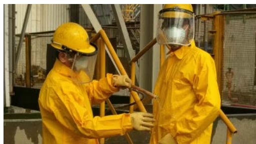
搶修完成後防護衣具除污
