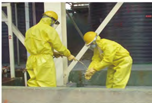
搶修完成後防護衣具除污
