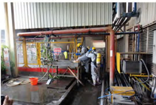
著裝組員進入槽區，進行液氨洩漏搶修
